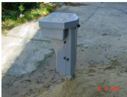
Rys. 2. Skrzynka kablowa SK01/CTI
